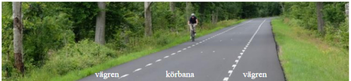
Figur 2-9 Utformning av en bygdeväg (källa: VTI).
